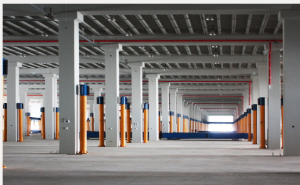
• 덕평 휴매드 물류창고 신축공사
